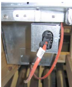
Figura 6: Conecte los conectores blancos de dos clavijas y enchufe el conector negro en el tomacorriente como se muestra. * Tome en cuenta que la posición de la conexión negra puede diferir de la foto.
